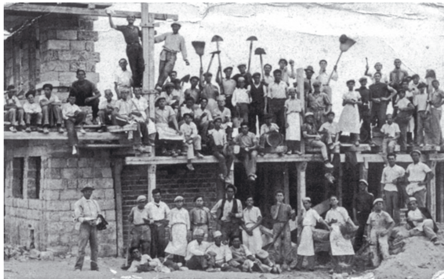
Estate 1938, maestranze della ditta Ceci in una pausa del lavoro sul cantiere per costruire "Il Brigantino", sulla Litoranea di Levante. Lo chalet fu inaugurato quell'estate stessa (16 luglio) dai committenti, i fratelli Giovanni e Pompeo Nigro, dal costruttore Donato Ceci, e dal progettista l'ing. Arturo Boccassini. (da RENATO RUSSO, Il Novecento, Editrice Rotas, 2008)
